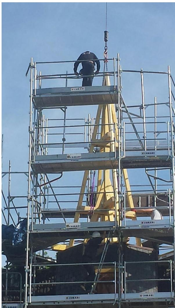
Une des premières étapes de la restauration du Pur Sang est en voie d'achèvement par la pose de la charpente du clocheton
